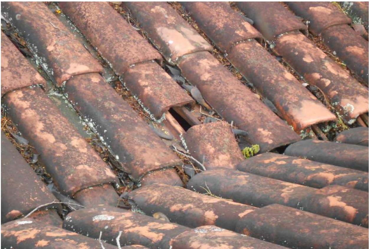
Foto 05 – Telhas quebradas.
